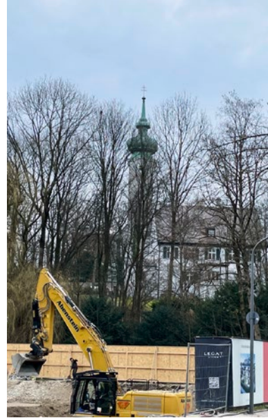
Der Abriss eines Wohnhauses an der Neuberghauserstraße ermöglicht einen neuen Blick auf Pfarrhaus und Kirche von St. Georg.
